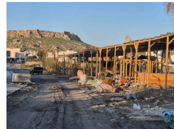
Am 31. März 2026 suchte das starke Unwetter „Eminio“ Rhodos heim und die Schulen wurden geschlossen. Im Strandbereich von Charaki sind noch die Schäden zu sehen.
