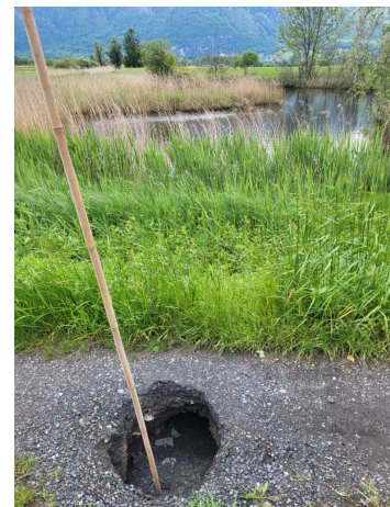
Biber legen ihre Höhlen auch unter Flurwegen an, die dadurch beschädigt werden können.
