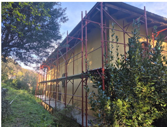
Das Haus ist eingerüstet ...
